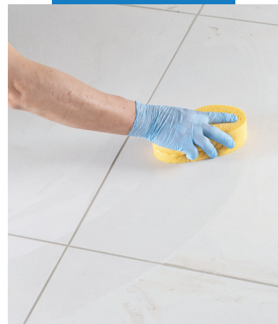
Čistenie a finálne dočistenie škár s použitím tvrdej celulózovej špongie
