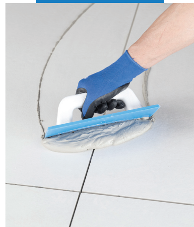
Aplikácia Ultracolor Plus s použitím gumovej stierky na porcelánovej dlažbe
