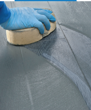
Čistenie a finálne dočistenie škár na podlahách s použitím tvrdej celulózovej špongie
