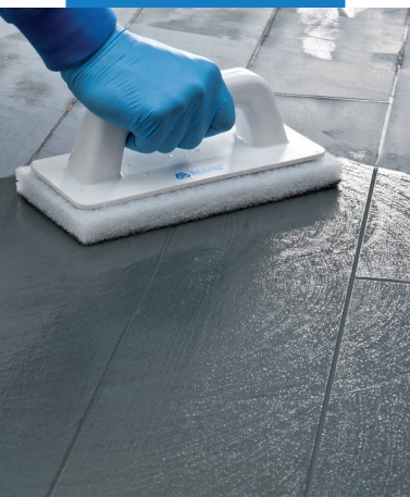
Čistenie škár s použitím Scotch-Brite® (po čiastočnom zatuhnutí)
